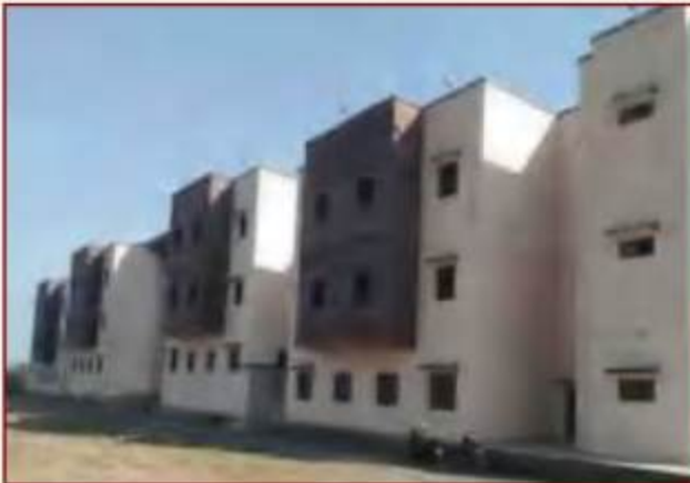
प्रयास आवासीय विद्यालय, बिलासपुर का नवनिर्मित भवन
