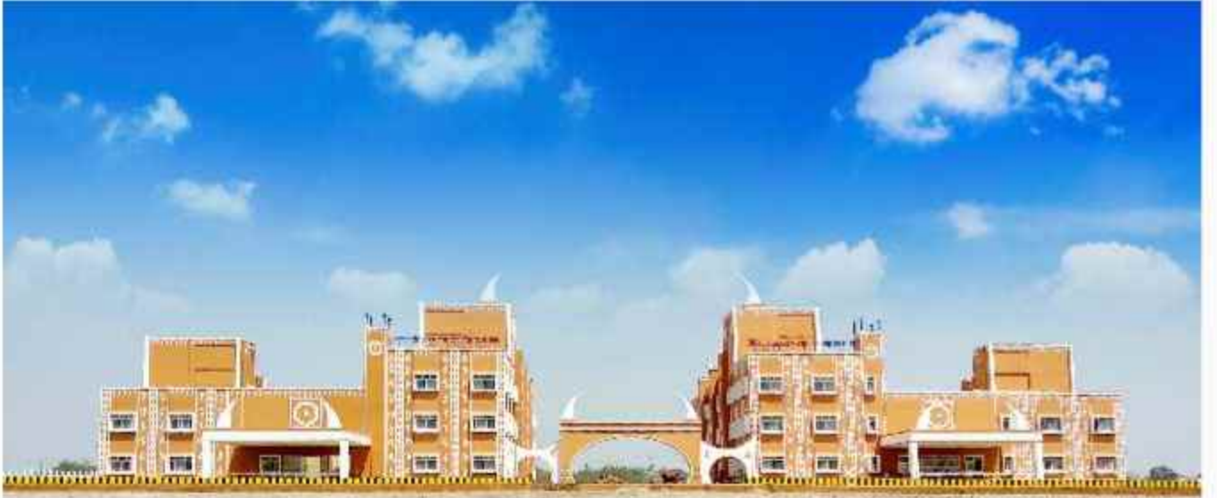
आदिम जाति अनुसंधान एवं प्रशिक्षण संस्थान का नवा रायपुर स्थित नवनिर्मित भवन एवं संग्रहालय
